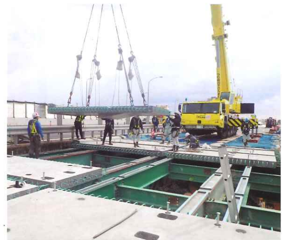
リニューアル工事実施状況
