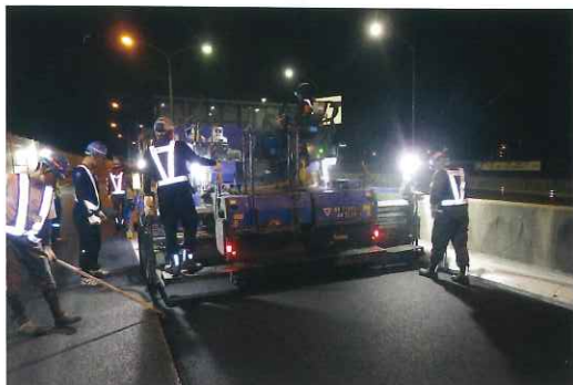
《舗装工事(イメージ)》
