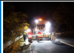
（舗装修繕工事）
