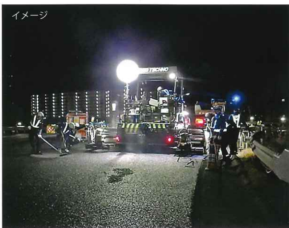
舗装補修工事
