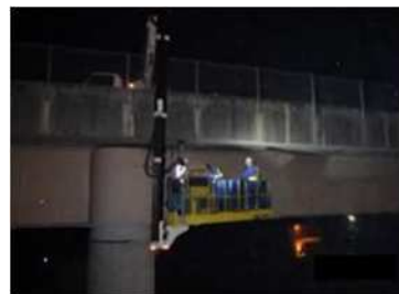
道路構造物点検 作業状況
