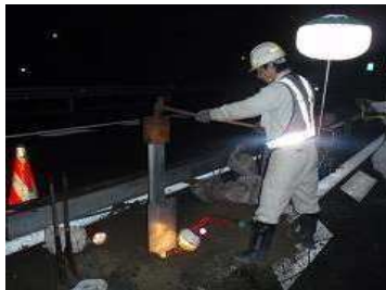
事故復旧工事 作業状況
