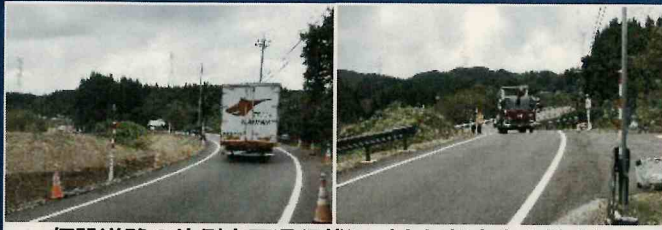
仮設道路の片側交互通行状況（小矢部市内山内）
