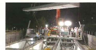
プレキャスト床版の施工
