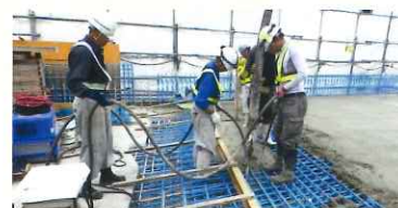
現場打ち床版の施工
