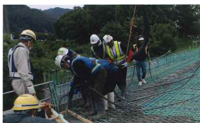
現場打ちコンクリート床版の施工
