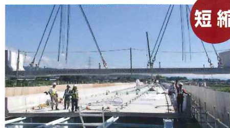
プレキャストコンクリート床版の施工
