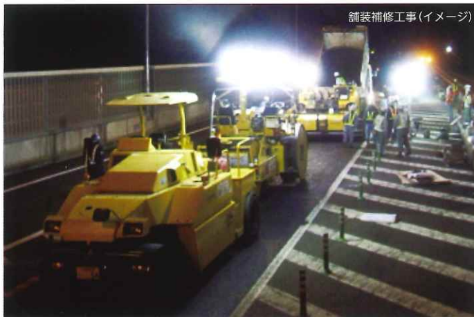
舗装補修工事(イメージ)
